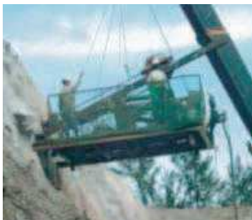
1. Soil Nail, Rock Bolt 천공 및 설치
