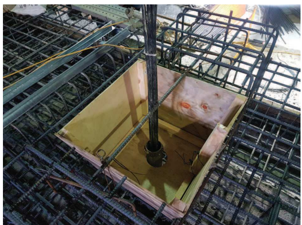
② 기초콘크리트 철근 배근 및 타설
