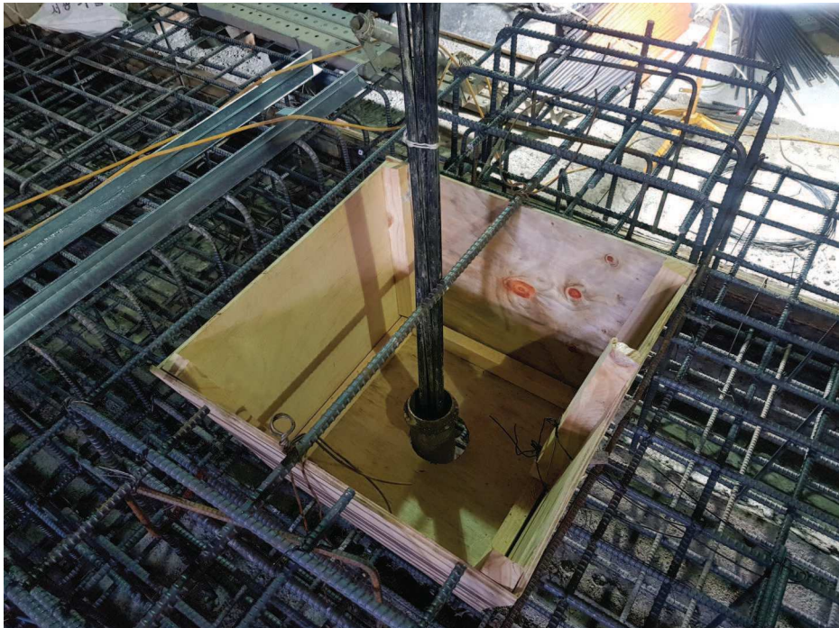
⑥ 기초콘크리트 철근 배근 및 타설
