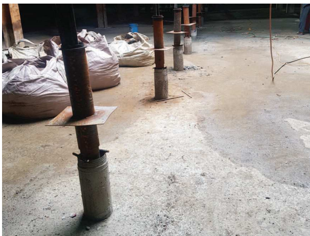
① 지수판 설치
