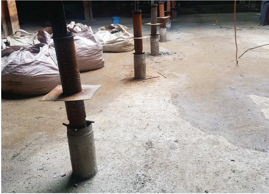
⑤ 지수판 설치
