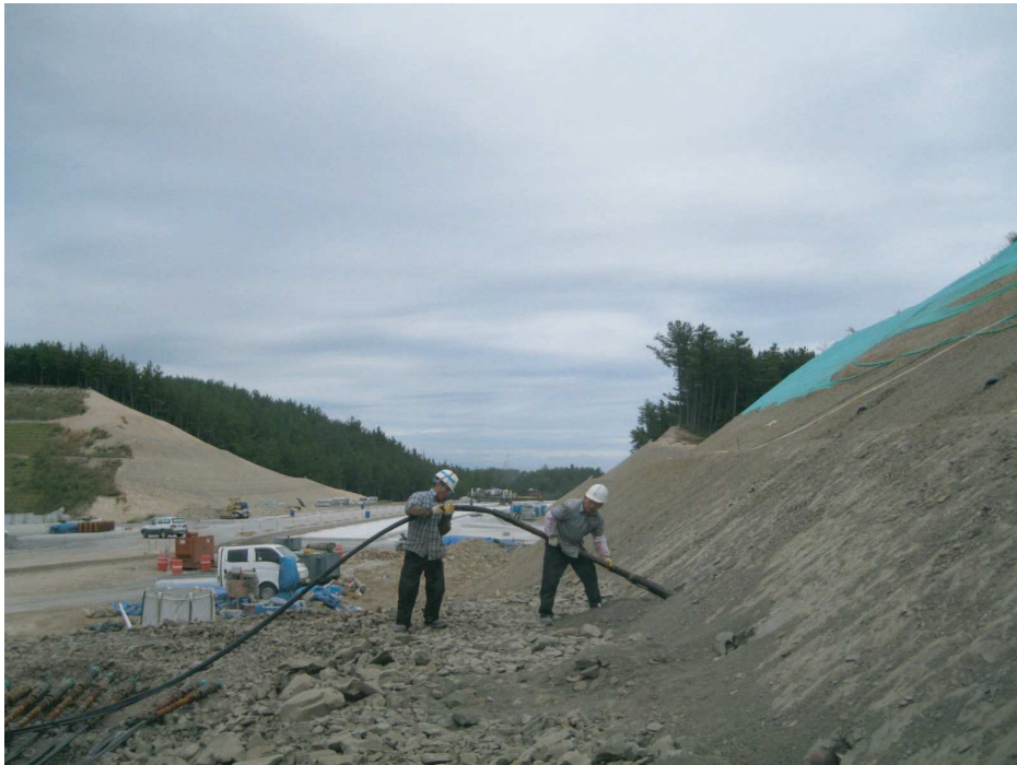
② SSL-SE 앵커 조립 및 삽입
