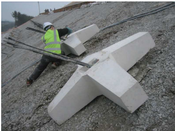
⑥ SSL-SE 앵커 수압판 설치
