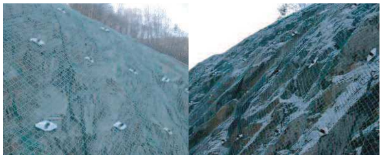
5. 시공 완료후 전경
